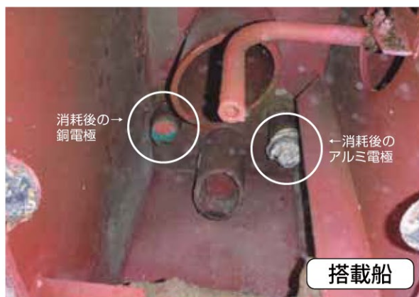
パイプガードを搭載したことにより海洋生物の付着を抑制でき、冷却水を確保した安全運航が可能に
